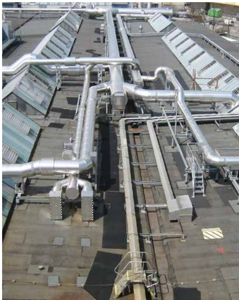
Dach der Anlage nach Umbau
