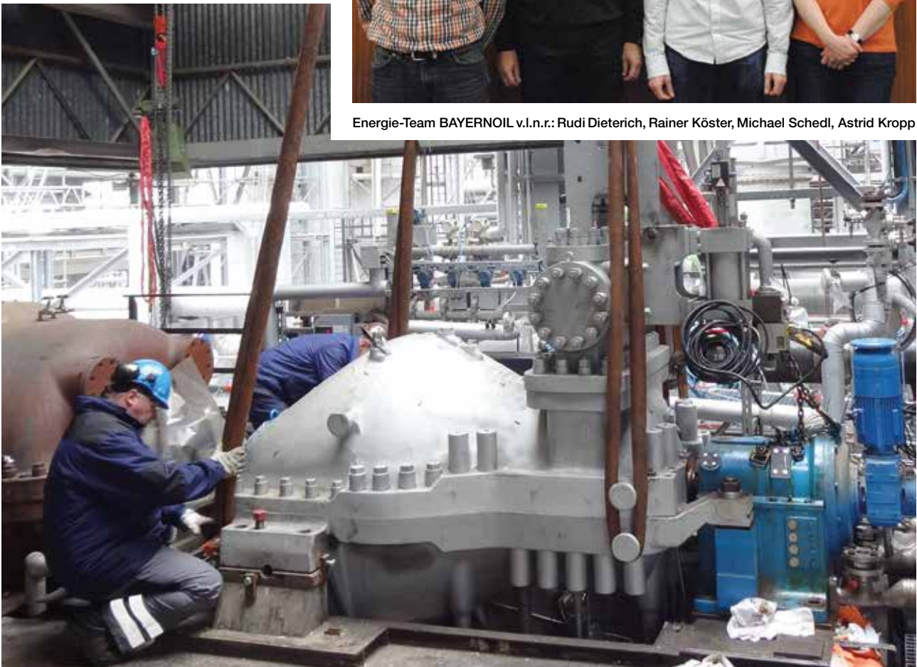
Montage der modifizierten Antriebsturbine für den Luftkompressor der FCC Vohburg
