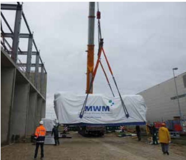
Lieferung BHKW Module
