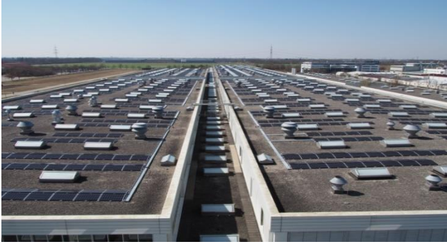
PV- Anlage 1,5 MW peak auf alte Dächer
